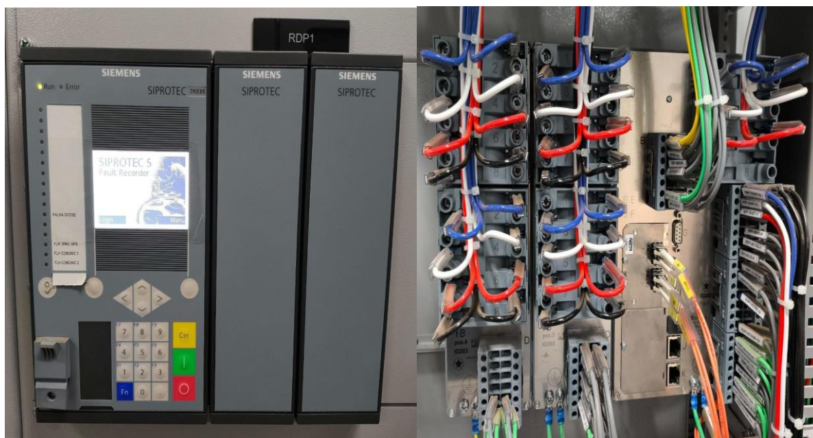
Figura 6: Registrador Digital de Perturbações da Siemens modelo Siprotec e as suas entradas de conexões.
