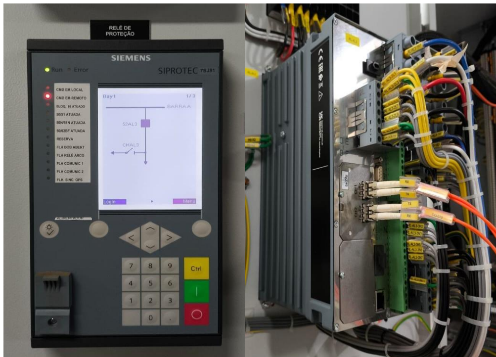
Figura 3: Relé de Proteção da Siemens modelo Siprotec e as suas conexões de entradas.
